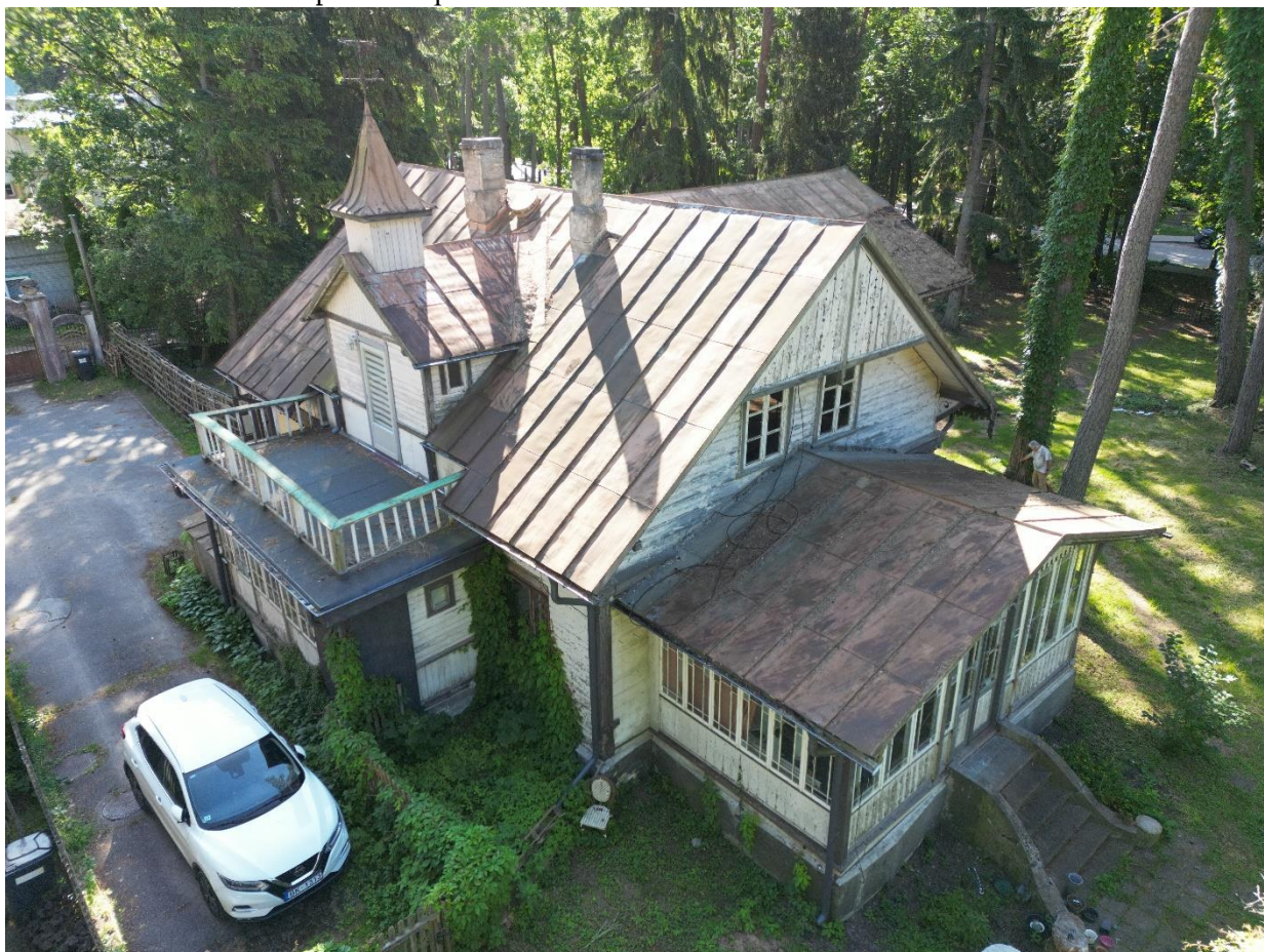
18. att. Ēka skatā no ZR puses
