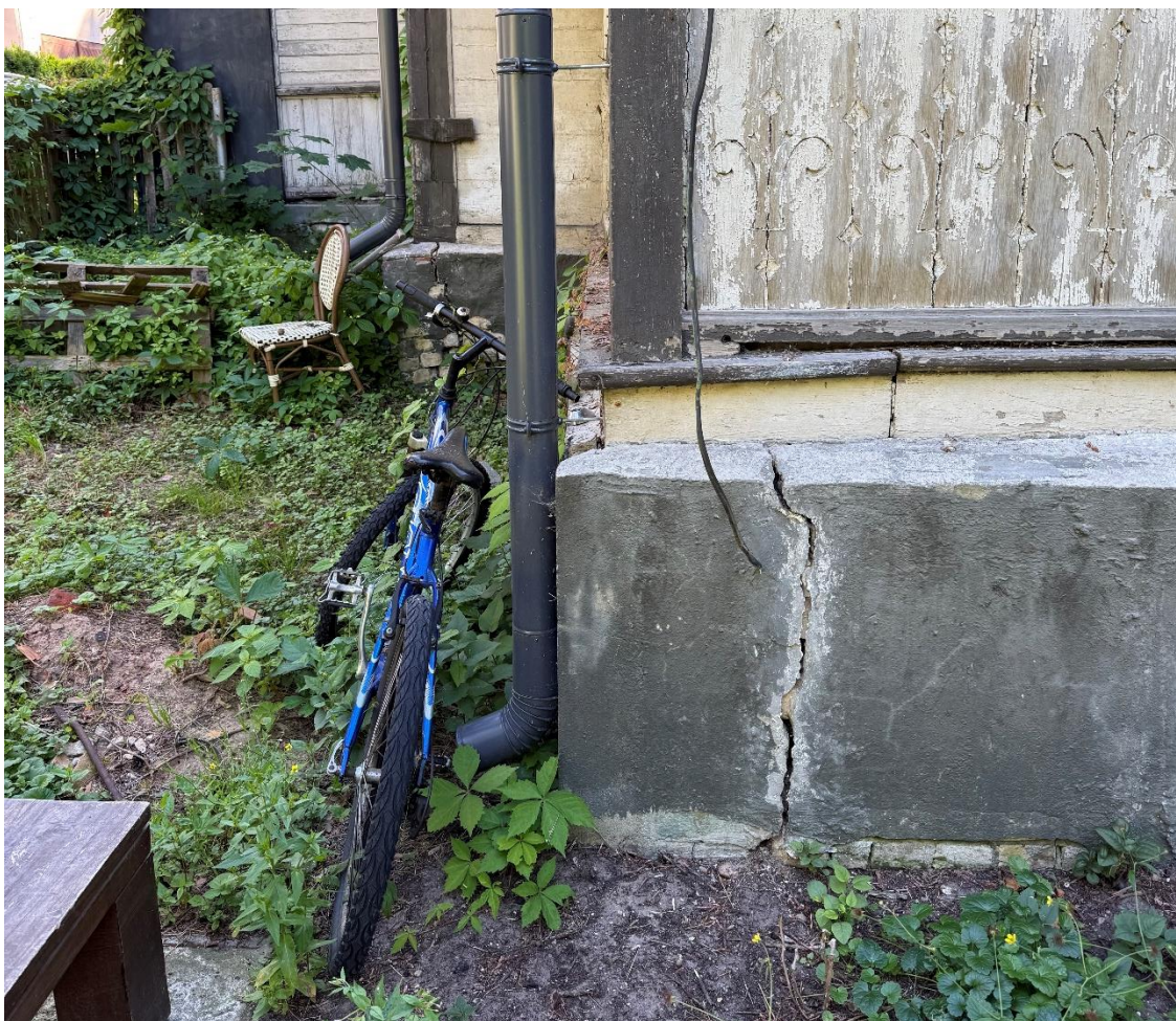
15. att. Lietus ūdens noteksislēmas notekcaurules nokrišņu ūdeni novada pie pamatiem. Virspamatos redzamas izteiktas plaisas
