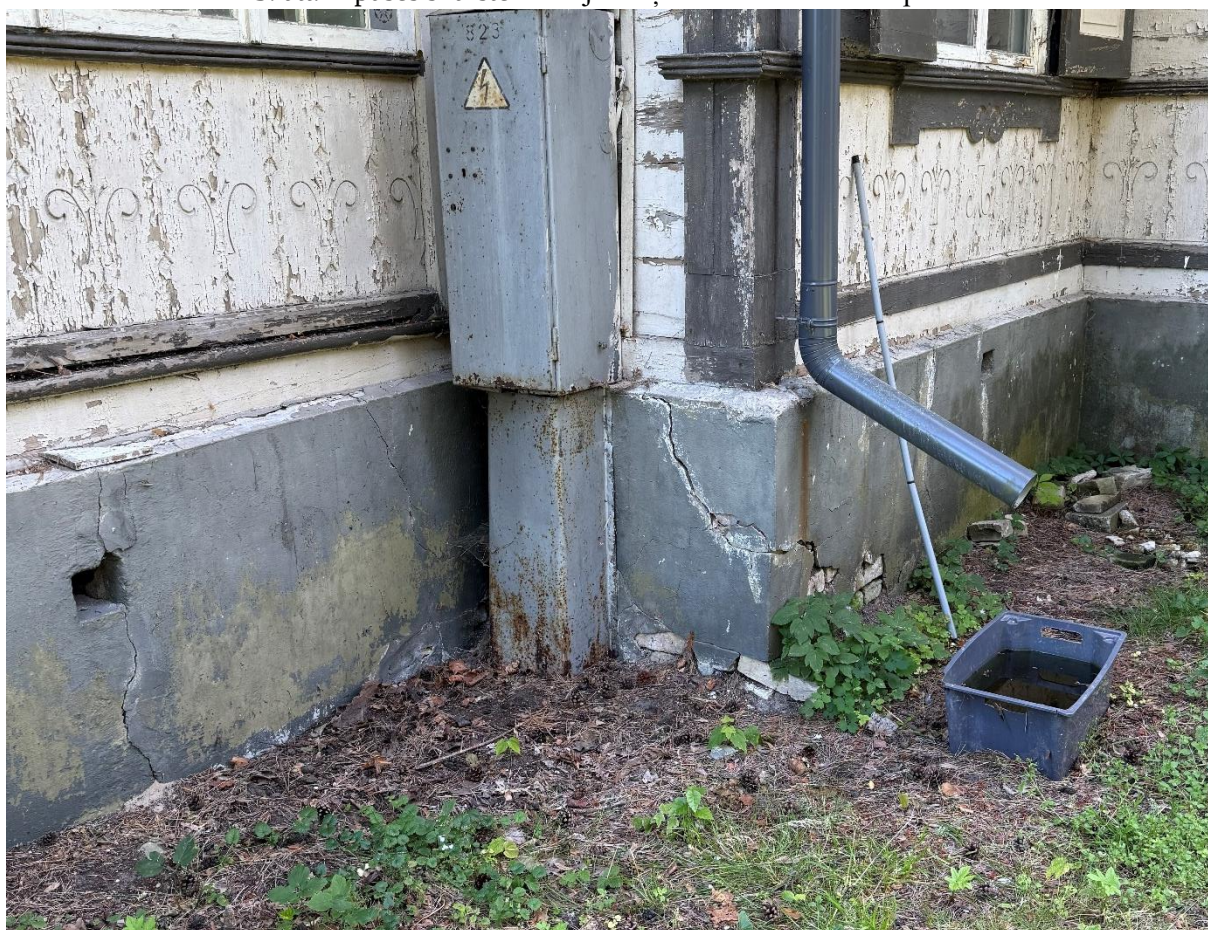
14. att. Lietus ūdens notek sistēmas notekcaurules nokrišņu ūdeni novada tvertnē pie pamatiem, tvertnei pārplūstot, ūdens nonāk, uzkrājas un skalojas gar pamatiem. Virspamatos redzamas izteiktas plaisas
